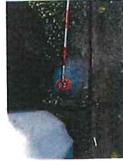
K3 新設金属板
