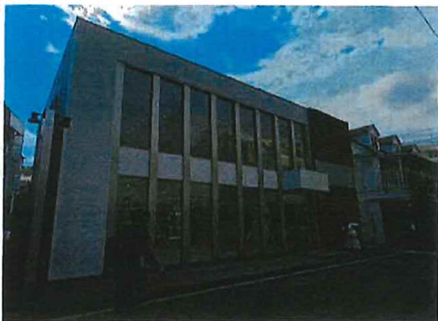
↑ 物件写真(外観)※2024年9月撮影
