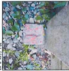
25-2 コンクリート杭
