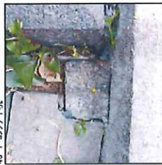
46-1 コンクリート杭
