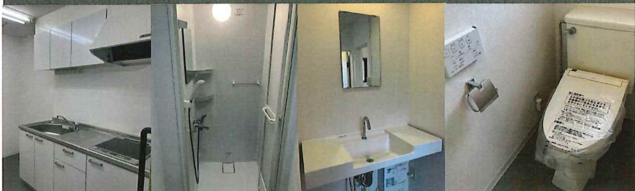
水回り新設（キッチン・浴室・洗面・トイレ）
