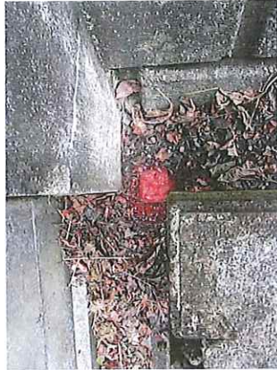
S5 既存コンクリート杭
