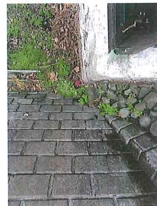
S3 既存コンクリート杭
