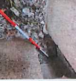
K5 コンクリート杭
