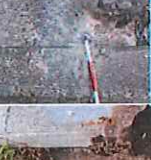
K6 コンクリート杭
