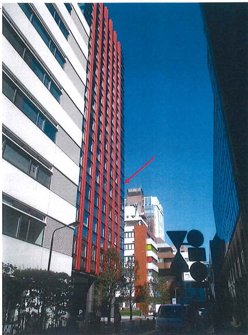
南東方より臨む (南東側道路)
