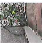
AK6 コンクリート杭
