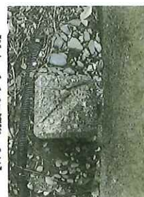
【K5 既設コンクリート杭】
