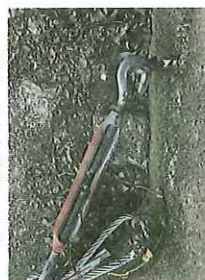
【K3 既設コンクリート杭】
