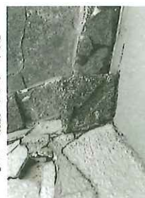
【K1 既設コンクリート杭】
