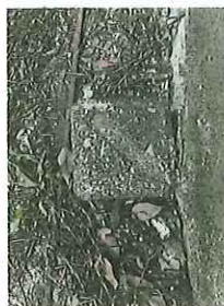
【K4 既設コンクリート杭】
