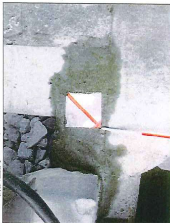
KA.4:新設金属プレート
