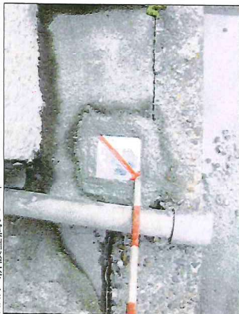
KA.1:新設金属プレート
