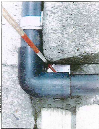
KA.2:新設金属標
