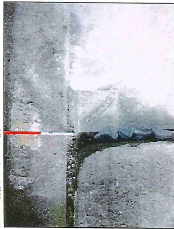
KA.3:新設コンクリート杭
