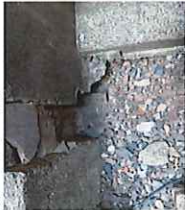
K92コンクリート杭
