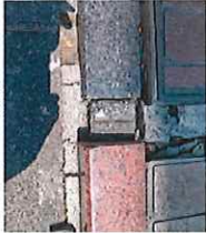
A2コンクリート杭方向
