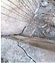
K97コンクリート杭
