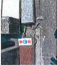
A4コンクリート杭方向
