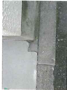
M6 コンクリート杭
