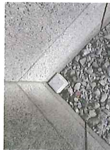
M4 コンクリート杭
