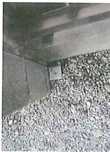
M3 コンクリート杭
