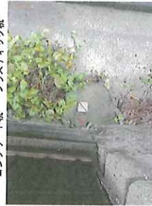
21 コンクリート杭 プラスティック杭
