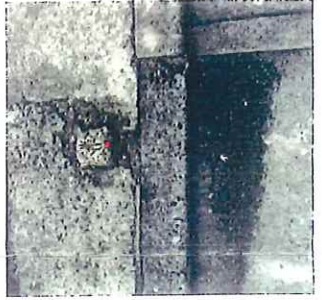
K1 (コンクリート杭)
