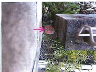
HA44 コンクリート杭
