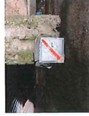
K3 金属標(既設)
