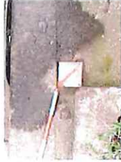
K5 金属標(既設)
