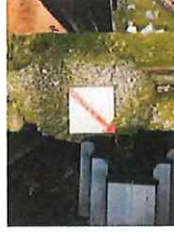
K4 金属標(既設)
