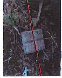
HK4 既設 コンクリート杭
